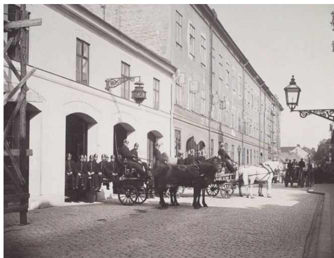
Brandstationen på Tjärhovsgatan år 1904
